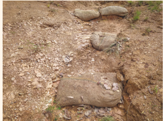
Uso de saco de juta para diminuir a velocidade da água em erosão. Foto: Bárbara Pacheco
